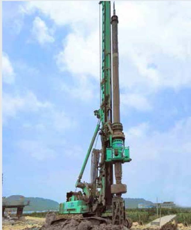
扩孔-三门湾大桥
